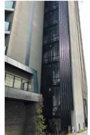
見付け・見込みの異なる複数種の縦線をランダムに表面に見せて構成することで、細い縦格子にさりげないリズム感をもたせた。外階段の目隠しスクリーンとファサードは同デザインで、ファサードには壁面緑化のためのワイヤーが組み込まれている
