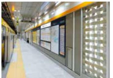
東京メトロ銀座線田原町の駅ホームに施工した面格子。アルミの幅広めのフラットバーを平織り状に組み、その網目の隙間から光がふわっともれ、照明の機能も併せ持つ。浅草らしい粋なデザインとなった
