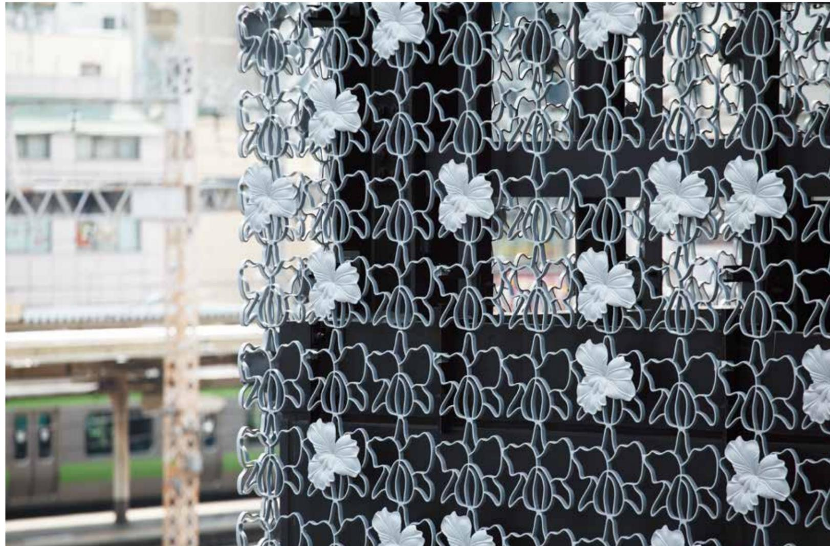
老舗百貨店松坂屋の上野店、その駐車場ビルの外装を広く覆うシェード。創業者・伊藤蘭丸祐道の「蘭」にちなんだカトレヤは、松坂屋のシンボルフラワーとして認知されており、デパートの包装紙としても女性たちに人気だ。そのカトレヤをロートアルミのオブジェで表面に散りばめ、ユニット自体もカトレヤモチーフを連ねたデザイン。奥行き16mm、見付けで5mmのかるやかな優雅さを感じさせる仕上がりとなっている。建物全体でも役物の例外はあるが4パターンの鋳物のユニットで設計されている。各ユニットは4か所の後ろアングルで固定する仕様で施工性も高く、これだけの面積を覆うためにはアルミの軽さもさることながら、延び性13%で耐震性にも優れ、竣工翌年となる2011年の東日本大震災にも耐えた。(16ページに記事)
