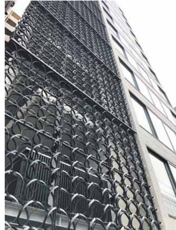
東京・東神田の柳原通りにあるスマートな12階建てビル。通りに面する外階段に、階段手摺とは別構造で目隠しスクリーンを設けた。三次元的に巻かれたリボン状のデザインとシックな色合いが、プレーンなコンクリート打ち放しに表情を添える
