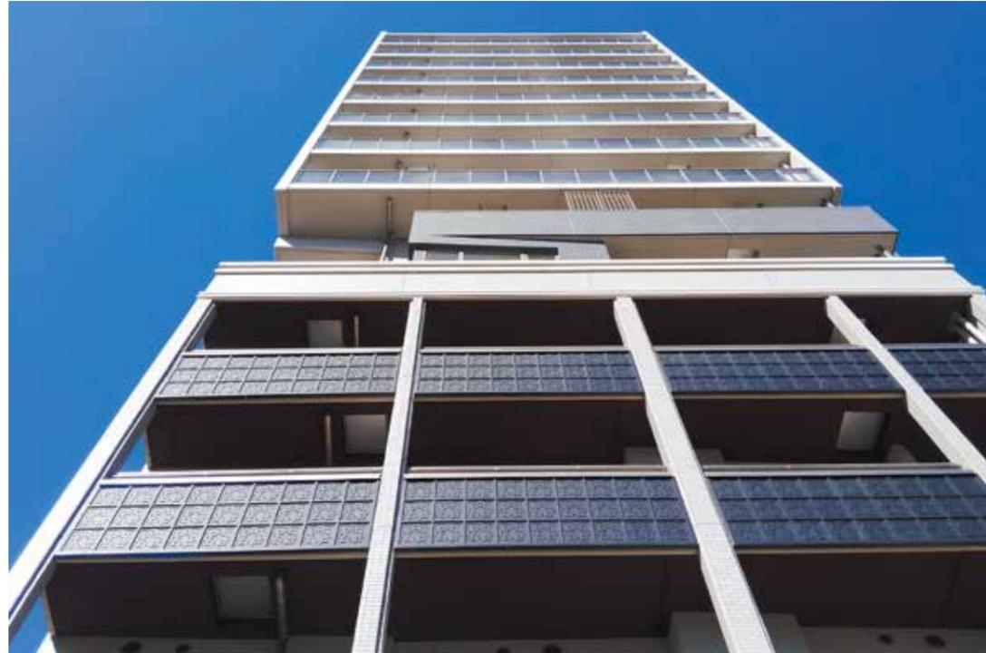
「明治時代からの由緒ある邸宅地に建つ洋館デザイン」をイメージした個性的な15階建てマンション。2~4階外観に施された幾何学モチーフのアルミ鋳物パネルは、洋館を思わせる雰囲気ある壁面装飾の役割を果たしている
