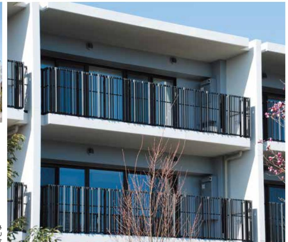
2015年、グッドデザイン賞に輝いた建物のバルコニー手摺。横棧の外側に縦格子を施工、鍛面で横のきざみを入れ、ハンドクラフトの温もりを感じさせる。低層の集合住宅にふさわしい静かなたたずまいを醸し出す
